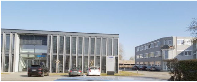
Max-Planck-Straße 10A – Blickrichtung Norden, auf Cepewa GmbH (Lage an Ostgrenze des Geltungsbereiches)
