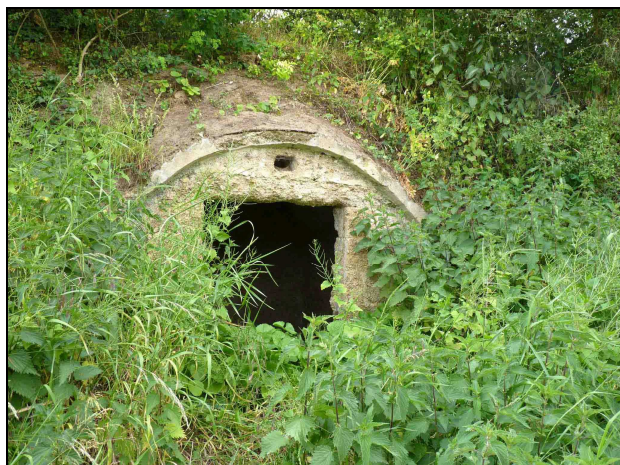
Abb. 3: Portal des schachtartigen Bauwerks in der Böschung der Heldenberger Straße.
