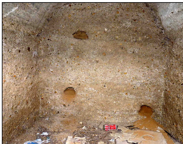
Abb. 4: Innenansicht des Bauwerks.
