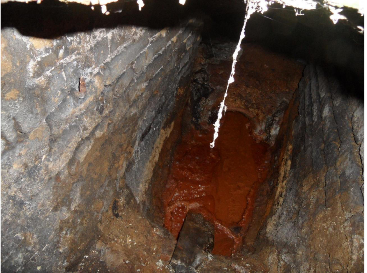
Abbildung 3-7: Blick auf den Abflusskanal unter dem Wohnhaus e' des Kellerraumes
