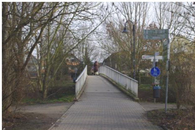
Ostseite Rathaus Brücke über die Nidda
