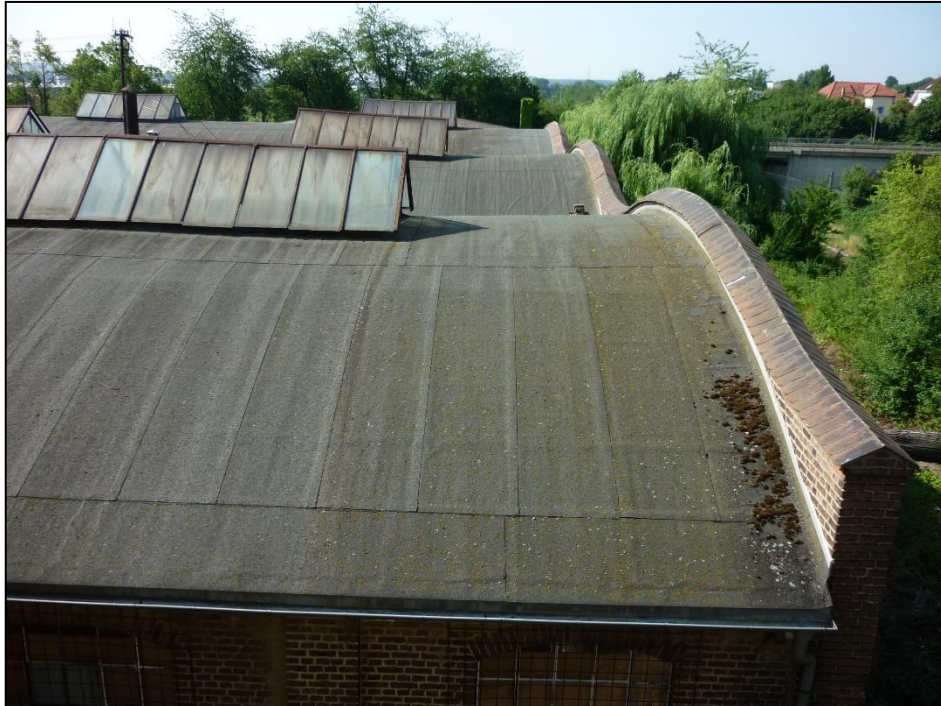
Abbildung 9: Dachfläche der Expeditionshalle des ehemaligen Brunnenbetriebs
