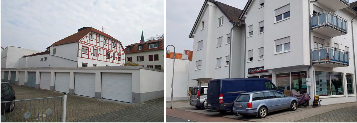
Abbildung 25: Aneinandergereihte Garagen eines Mehrfamilienhauses (links), dem Gebäude zugeordnete oberirdische Stellplätze (rechts) (Quelle: eigene Aufnahme)
