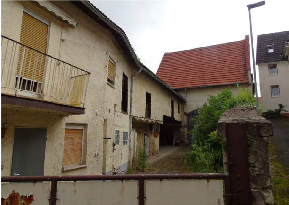
Abb. 4.: Alte Scheunen an der Rittergasse, 12.07.2019
