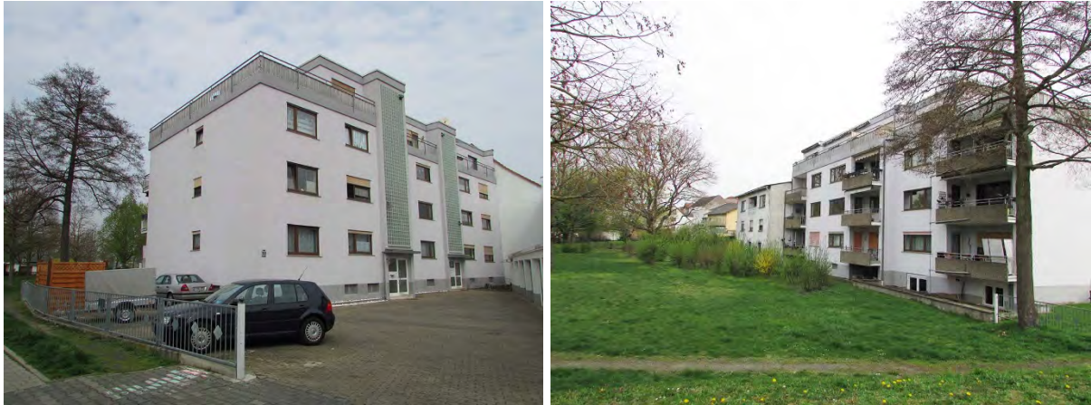
Abbildung 20: Dreigeschossige Gebäude westlich der Dortelweiler Straße in rückwärtiger Lage (Quelle: eigene Aufnahme)
