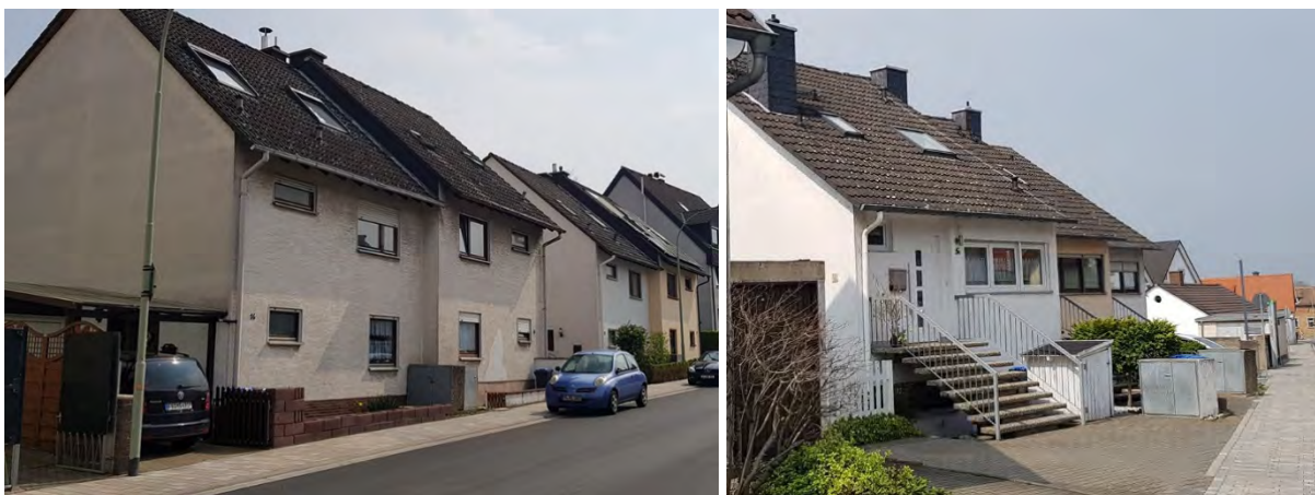
Abbildung 19: Doppelhäuser und Reihenhäuser in der Rendeler Straße (Quelle: eigene Aufnahme)
