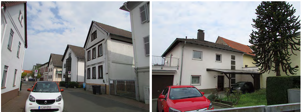
Abbildung 21: Satteldach und Walmdach innerhalb des Plangebietes (Quelle: eigene Aufnahme)
