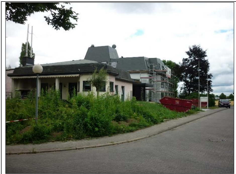
Abbildung 15: Blick auf das Hotelgebäude
