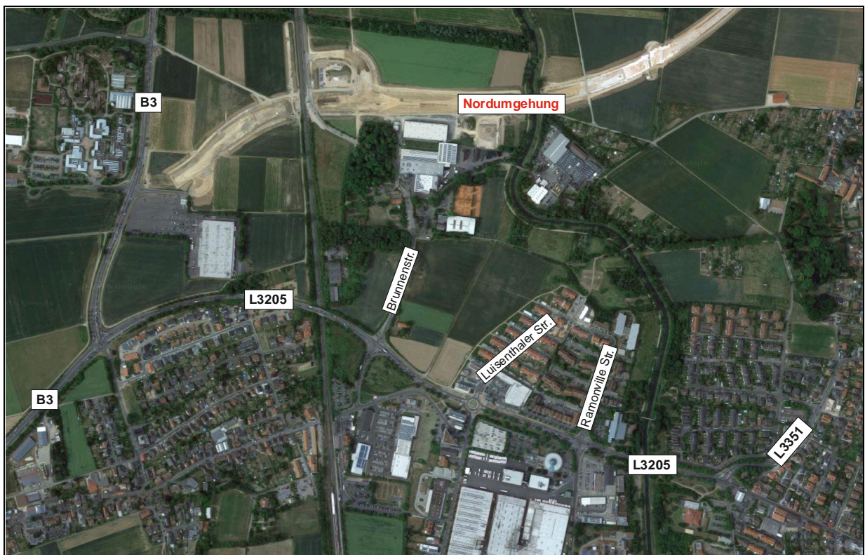
Bild 1: Bereich L3205 zwischen B3 und L3351
