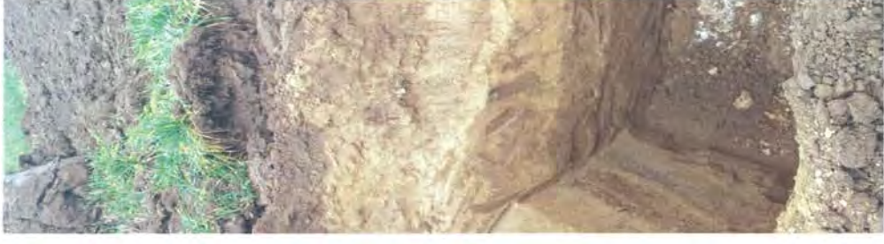
Bild 4: Schurf 4 (S von 3,3 m unter GOK in der Sohl
