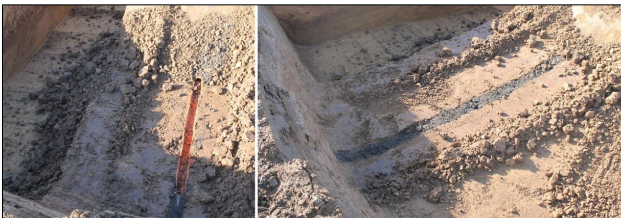
Abb. 7: Drainageleitung in Schnitt 1, Fläche 1; Links: Röhren, Blickrichtung Ost; Rechts: Schotter-/Schlackebett, Blickrichtung Südost (Fotos: E. Biermann).
